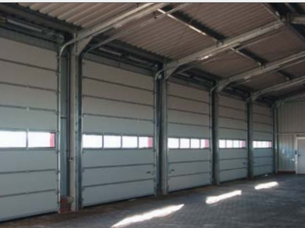
Секционные ворота SW со стандартным подъемом и движением полотна вдоль крыши.
