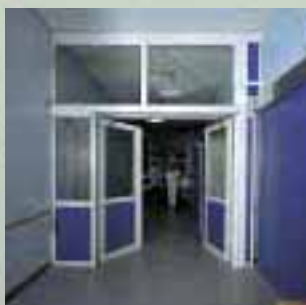
Серия FLY PB 2100 Автоматические системы интенсивного использования для двухстворчатых распашных дверей массой каждой створки до 250 кг
